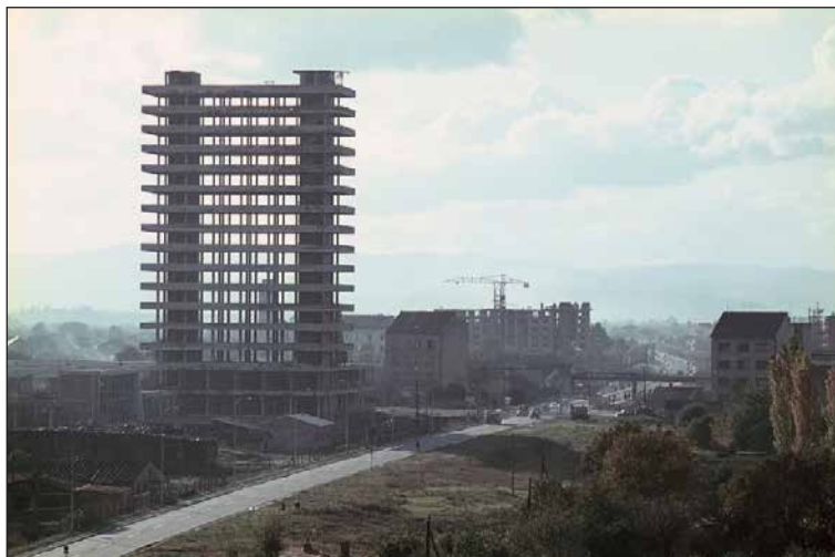
Slika 10: Izgradnja Vjesnika 1964. (Foto: Facebook stranica Zagreb - Kakav je bio nekada)
