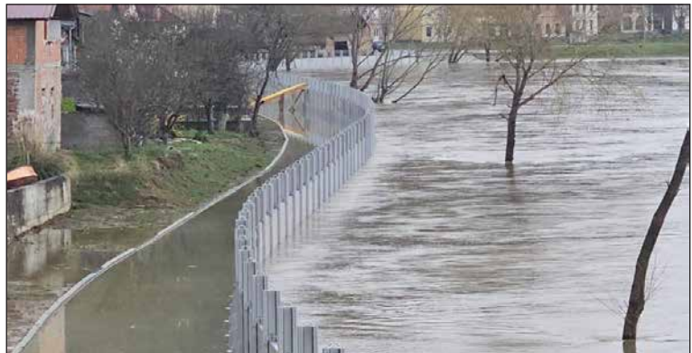
Slika 2. Montažno-demontažna barijera (Izvor: Obrada autora [3 - 5])
