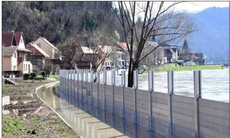
Slika 1. Novi montažno-demontažni sustav u Hrvatskoj Kostajnici (Izvor: Obrada autora [3 - 5])
