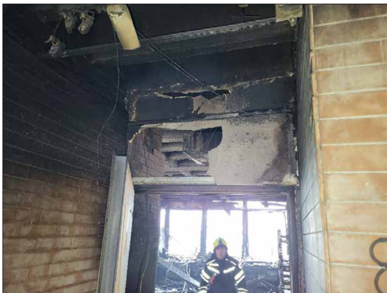
Slika 17: Neusklađenost protupožarnih svojstava vrata i nadvoja kompromitira učinkovitost sektorizacije.
