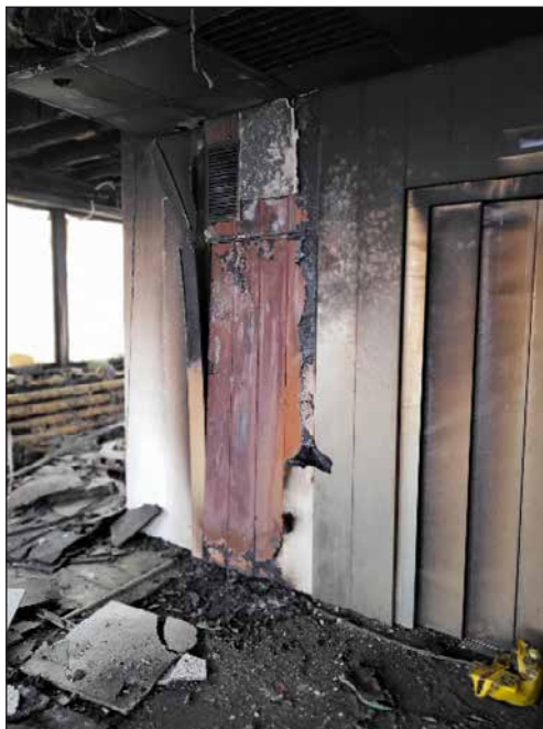
Slika 9: Prekrivena vertikala za instalacije (Foto: Vatrogasna postrojba Zagreb)
