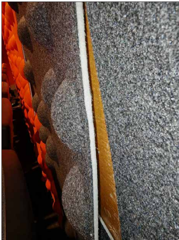
Slika 5: Utjecaj starenja akustičnih panela (Izvor: slika autora)
