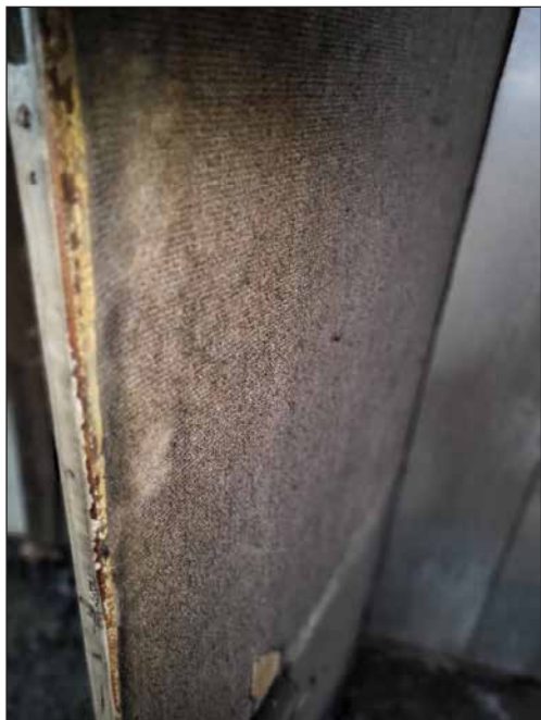
Slika 8: Prekrivena vertikala za instalacije (Foto: Vatrogasna postrojba Zagreb)
